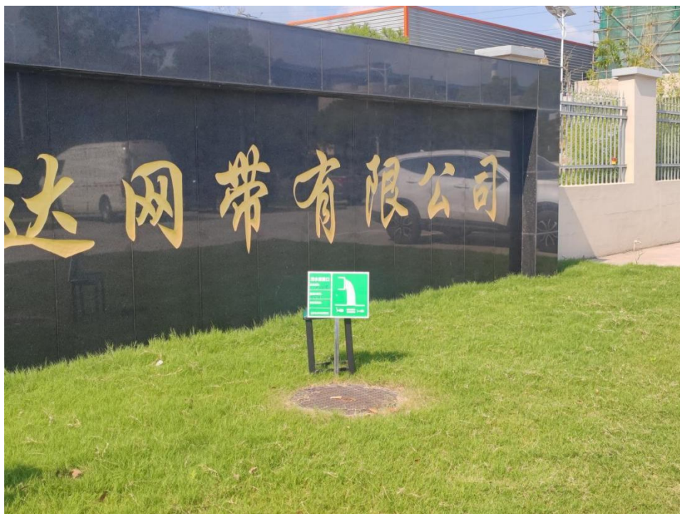
图 3-1 污水总排口及标识牌
